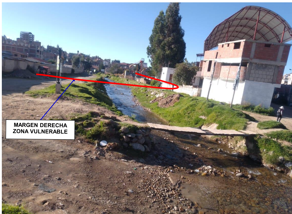
FIGURA N° 02: RIO CONDE EXPUESTO ANTE SOCAVAMIENTO EN AMBAS MARGENES A LA ALTURA DE CONDE PAMPA CERCADO DEL DISTRITO DE SANTO TOMAS.
