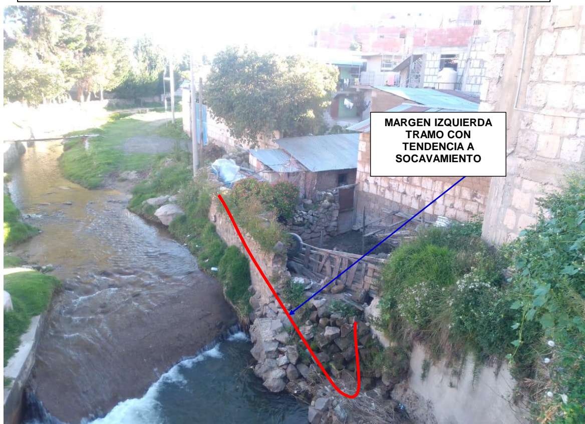
FIGURA N° 03: RIO CONDE EN LA TEMPORADA DE MAXIMAS AVENIDAS AFECTO CON SOCAVAMIENTO POR LA MARGEN IZQUIERDA VIVIENDAS DENTRO DE FAJA MARGINAL.
